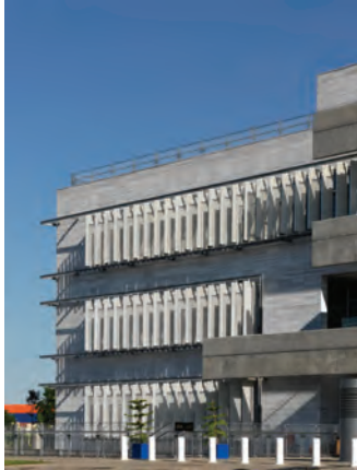
18. Cephede çekiçlenmiş Marmara mermeri uygulaması ve güneş kırıcı paneller
