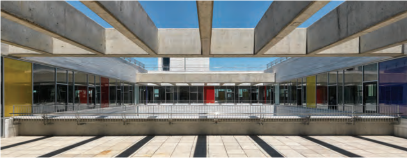
11. Üst kotta yer alan ve geçide bakan teraslar
