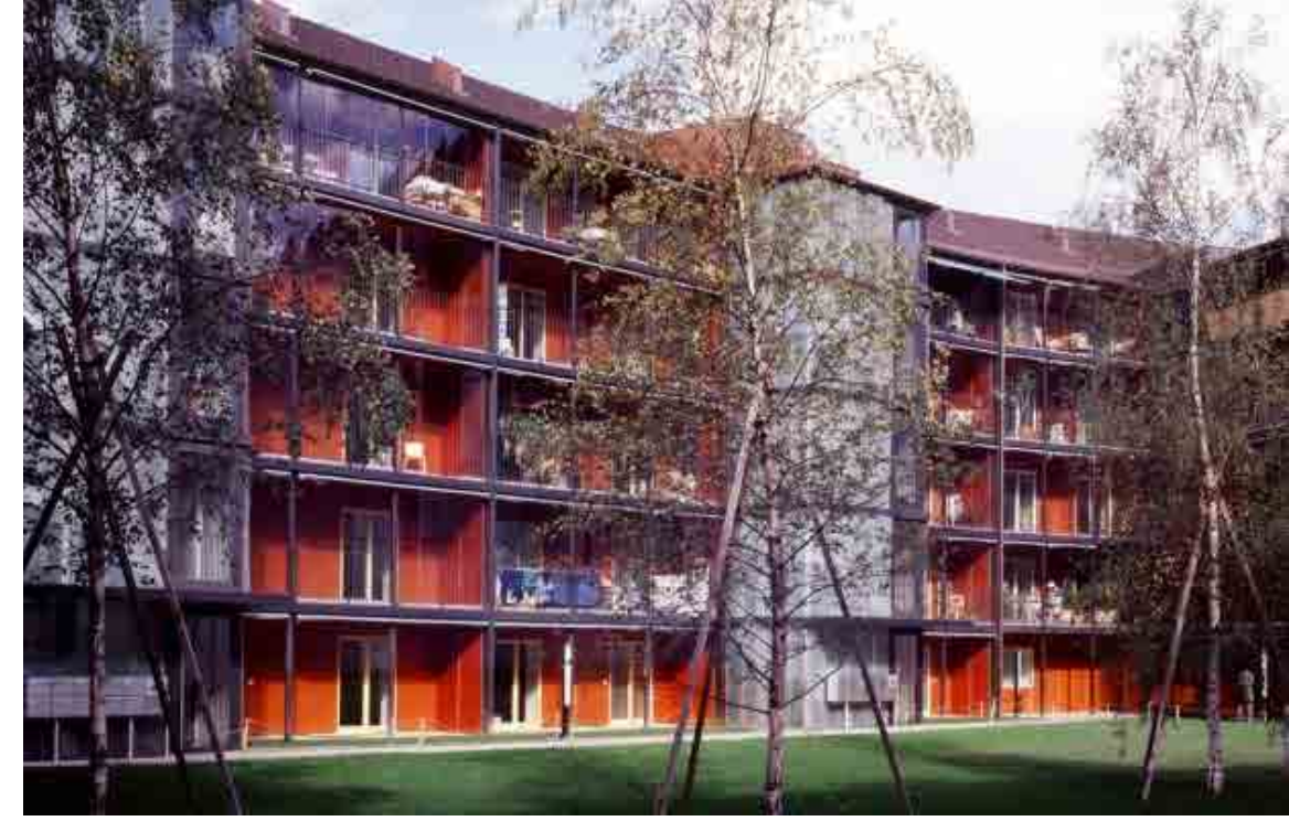
Görsel 5: Tivoli konutları onarım sonrası arka cephe / Fotoğraf: (D. Jungling und A. Hagmann Architekten)
