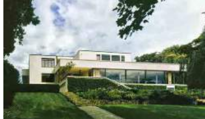
Görsel 1: Villa Tugendhat onarım sonrası Fotoğraf: Libor Teplý (Divisare, 2016)
