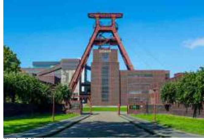
Görsel 10: Zollverein onarım sonrası müze yapısı Fotoğraf: Jochen Tack, 2013 (Internationale Bauausstellung, ty)
