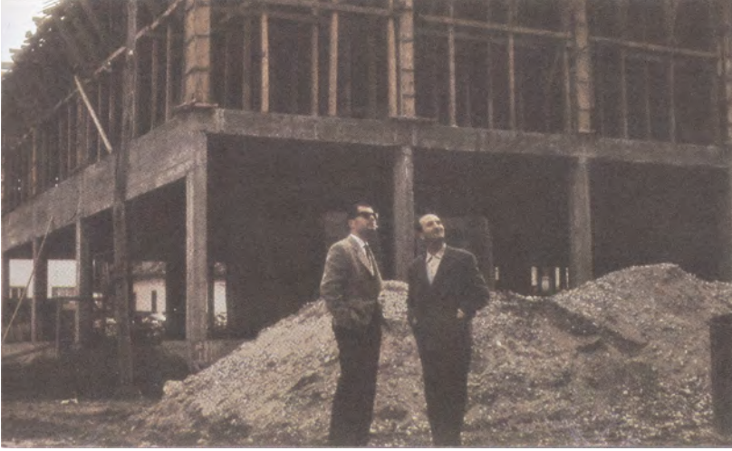
1. Enis Kortan ve Nişan Yaubyan, Sakarya Hükümet Konağı inşaatında
